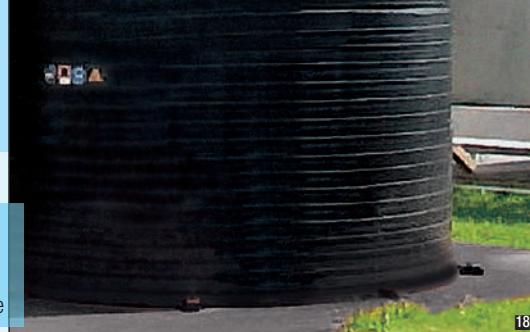
Verticale aérienne – Structure autoporteuse
