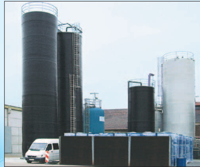
Zwei Doppelwandbehälter aus PE-HD, Durchmesser: 4.000 mm, Höhe: 17.120 mm, Inhalt: 200.000 Liter
